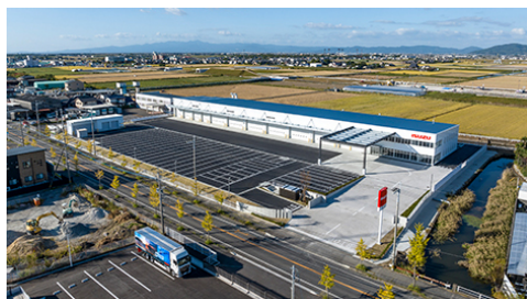
いすゞ自動車九州（株）佐賀サービスセンター
