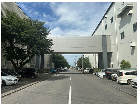
倉庫間に設置された高架橋
